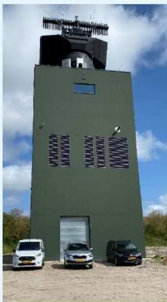
figuur 3: foto van zuidgevel van radarantenne
